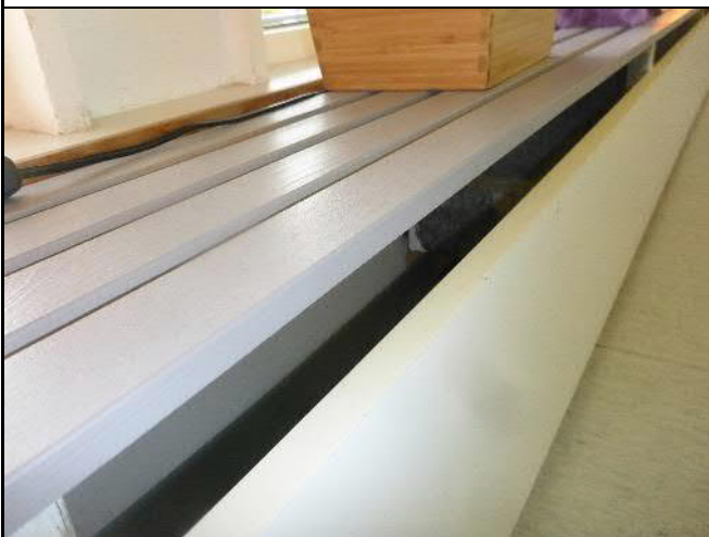
Kuva 59. Ikkunan alla oleva patterin suojana oleva panelointi heikentää siivottavuutta ja pöly kertyy paneloinnin taakse.
