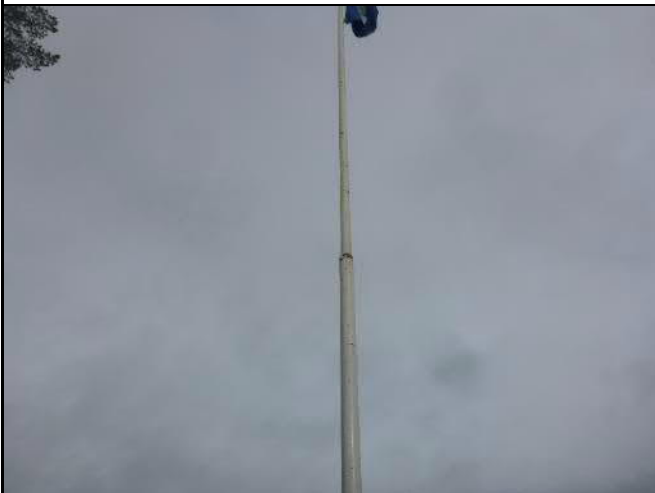
Kuva 9. Pihalla sijaitseva lipputanko, alkavaa ruostepilkkua on jo laajasti.
