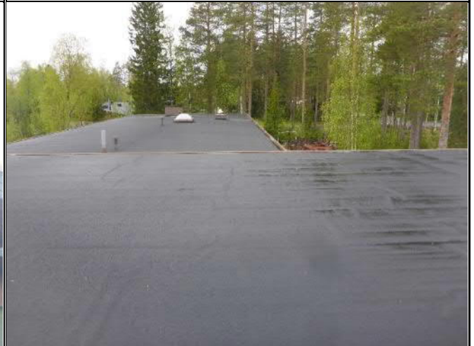
Kuva 40. Vesikatto pääsääntöisesti hyvässä kunnossa.
