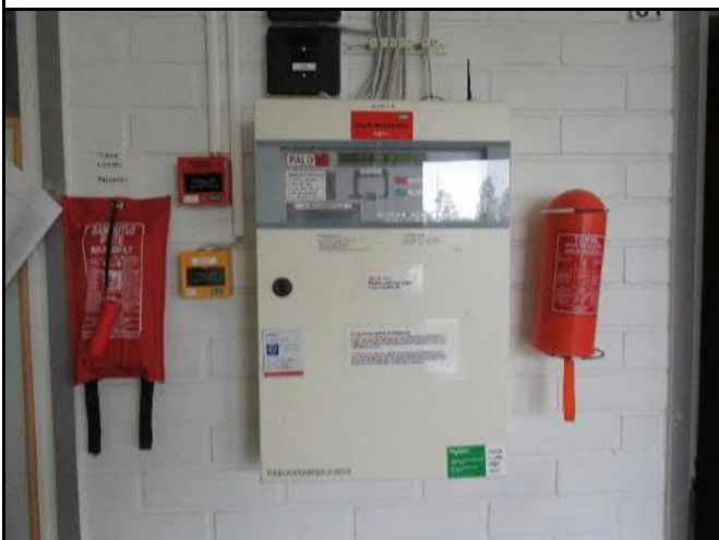
Kuva 15. Kiinteistön paloilmotinkeskus
