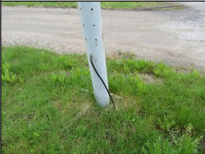
Kuva 9. Mainosvalon ryhmäjohto suojaamatta
