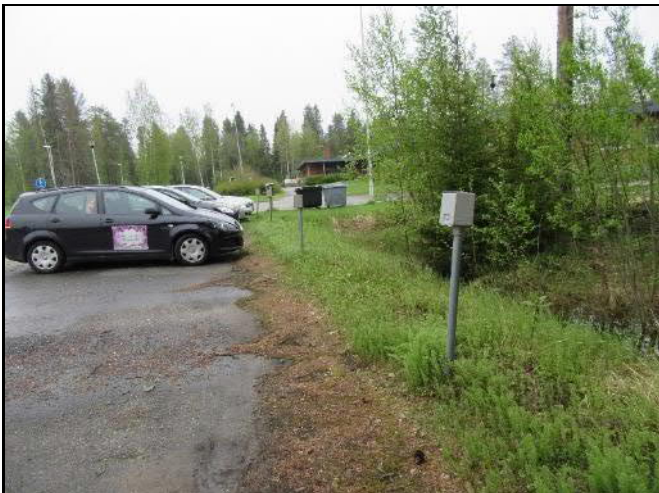
Kuva 13. Autolämmityskoteloita vinossa
