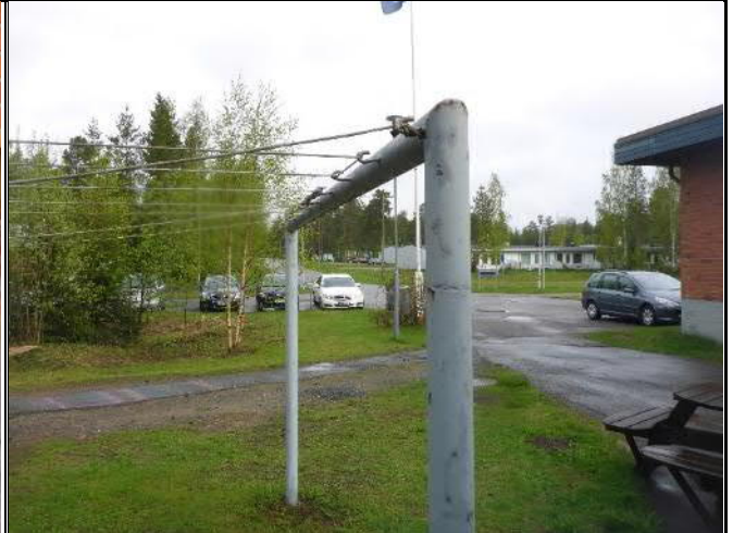
Kuva 8. Pihalla sijaitsee kiinteä pyykkiteline, joka on tyydyttävässä kunnossa. Pientä ruostumista esiintyy mutta se ei haittaa käyttöä.
