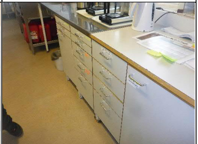
Kuva 54. Keittiön kalusteet ovat kolhiintuneet ja teräsjalat ovat ruostuneet.
