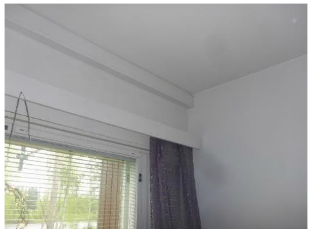
Kuva: tuloilma korvausventtiili makuuhuoneissa
