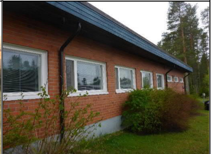
Kuva 22. Tiilirakenteinen julkisivu, jossa on uusitut ikkunat.
