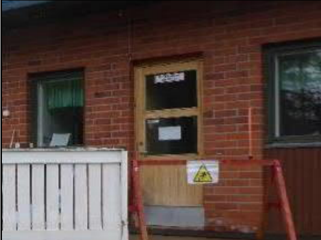
Kuva 31. Puurakenteinen ulko-ovi luoteisterassilla. Oven pinnat kuluneet.
