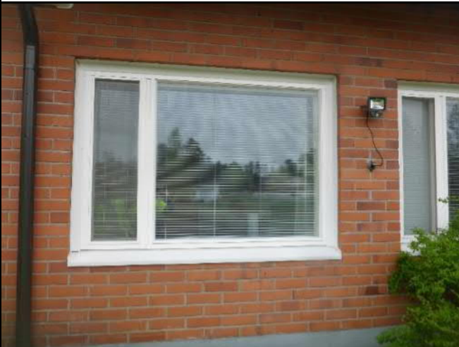
Kuva 27. Uusi kolmilasinen metallirakenteinen ikkuna.
