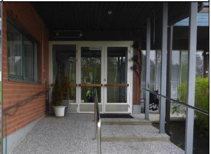
Kuva 30. Metallirakenteinen ulko-ovi pääkulkureitillä. Kunto hyvä.
