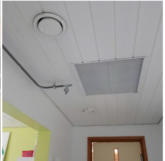
Kuva: Sprinklerisuutin
