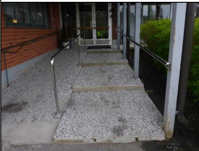
Kuva 35. Loivat betoniportaavat ja betoniliuska pääkulkureitillä.
