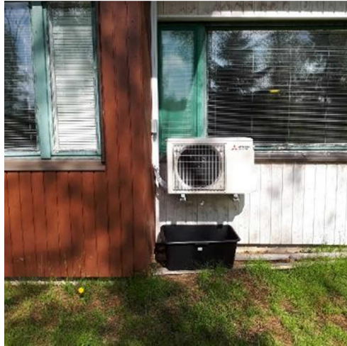
kuva: ilmalämpöpumppu
